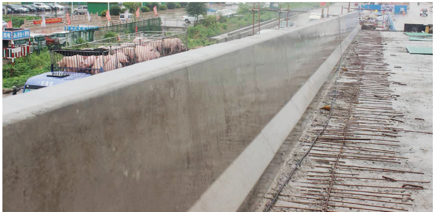
一公司温泉路 混凝土护栏线型美观
